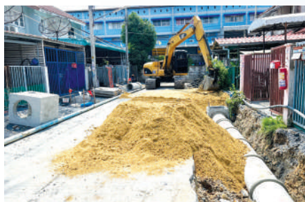
โครงการยกระดับผิวจราจร บริเวณถนนซอยหมู่บ้านเสรีวิลล์
