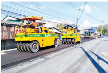
โครงการยกระดับผิวจราจร บริเวณถนนสายเสธง-บัวโรย
